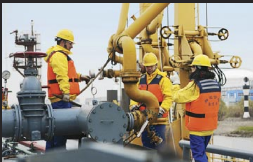
In alto: Centrale elettronucleare a Sanmen, dotata di due reattori AP1000, 9 ottobre 2019, IAEA In basso: Impianto per l'estrazione di shale gas (gas ricavato da argille), 22 dicembre 2017, BASF
